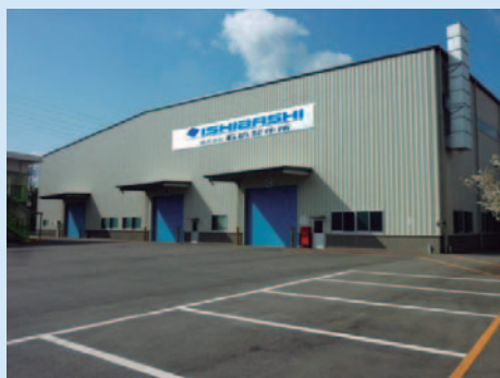
写真：石橋スキルテックセンター外観
