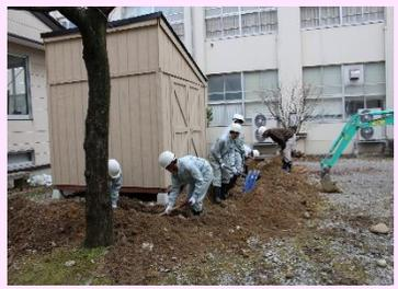
写真：土木科による地中埋設配管の様子
