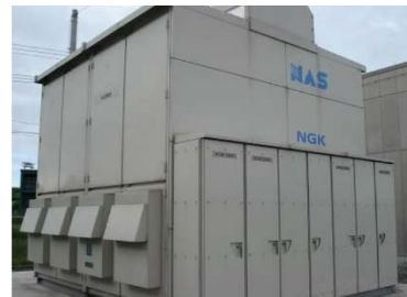
大型蓄電システム施設
