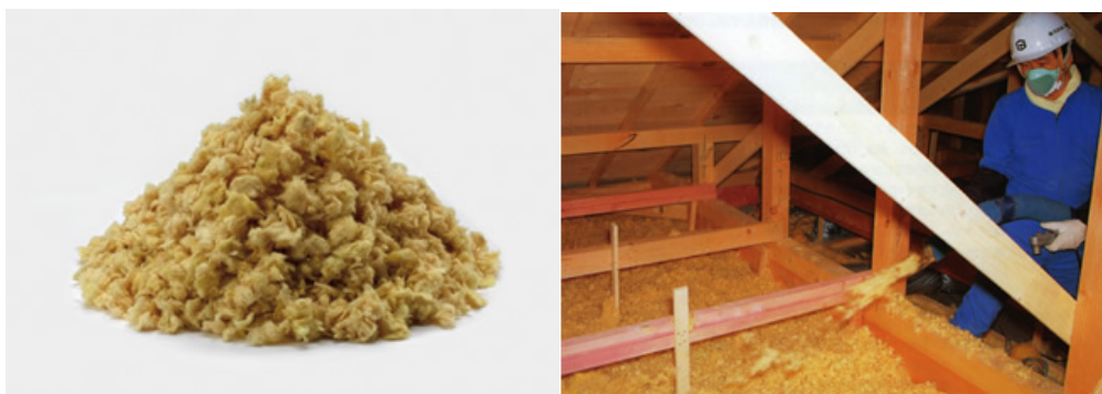
図表 2.4.1 吹込用グラスウール断熱材と天井施工の様子
