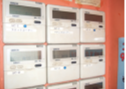
エアコンの番号に番号を付けて電源投入管理
