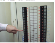
配電盤で、店舗の電源投入時(06:30～11:00)によって段階的にON、OFF
