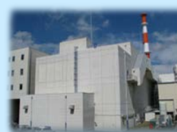
Pu転換技術開発施設
