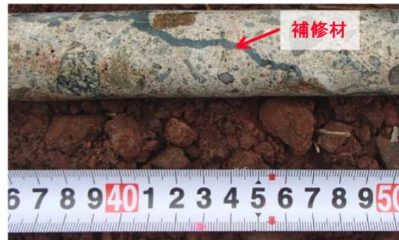
9号機の供試体の補修材確認
