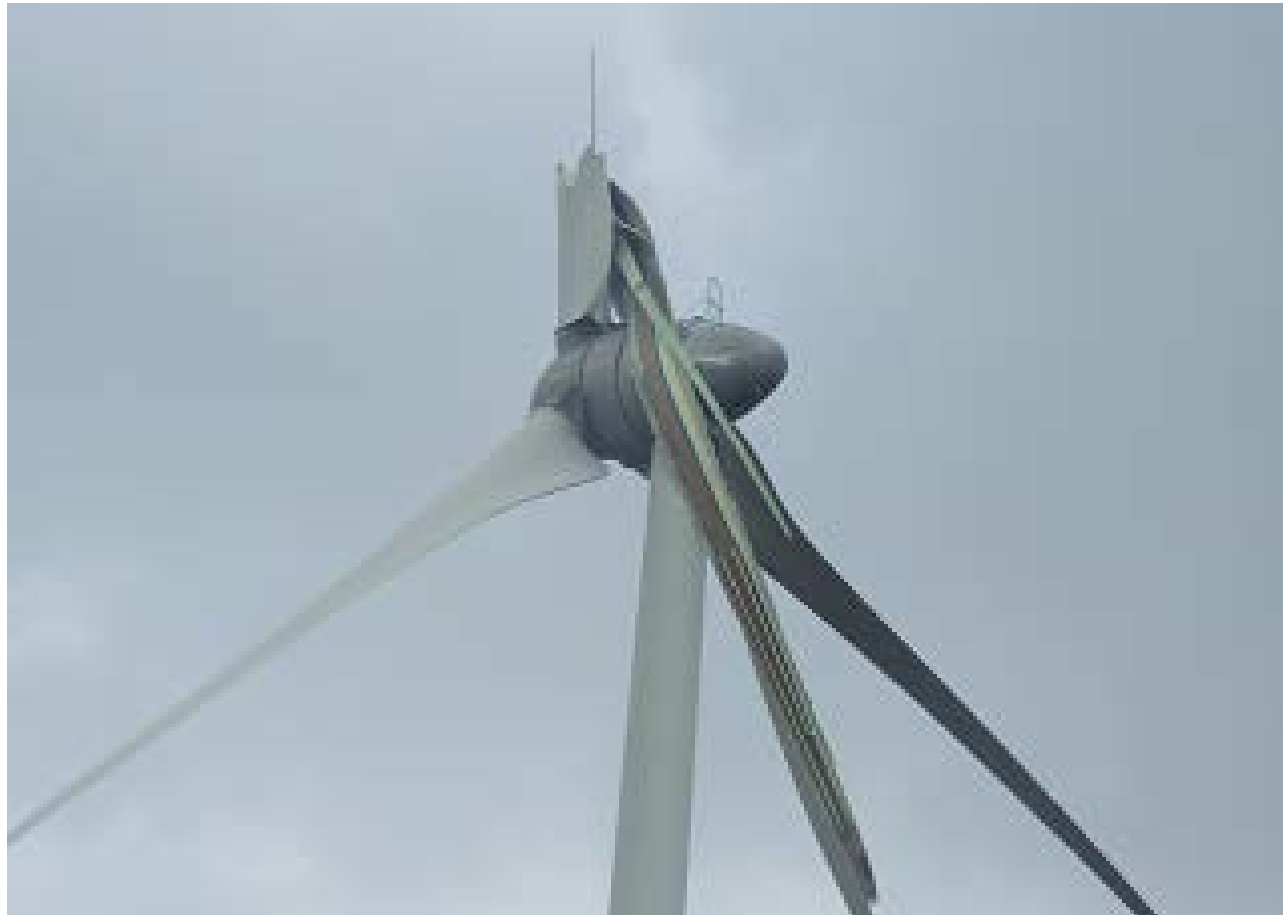
写真2 風車損傷状況
