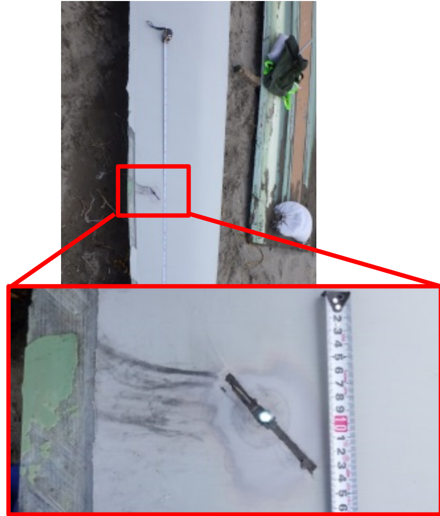
写真5 ブレード損傷箇所（地上での撮影）
