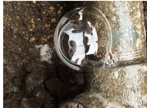
写真2 支管ねじ接合 その2
