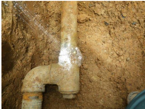
写真1 支管ねじ接合 その1
