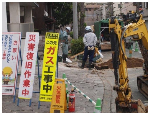
写真12 本支管修繕 その1
