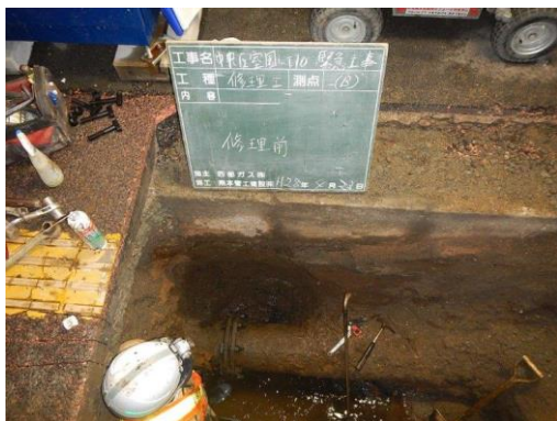
写真3 本管機械的接合 その1
