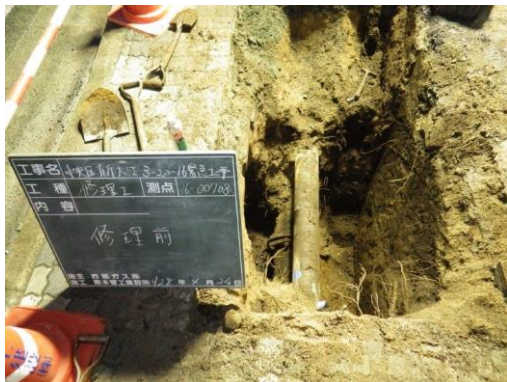
写真5 本管機械的接合 その2
