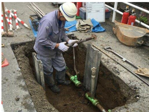
写真13 本支管修繕 その2
