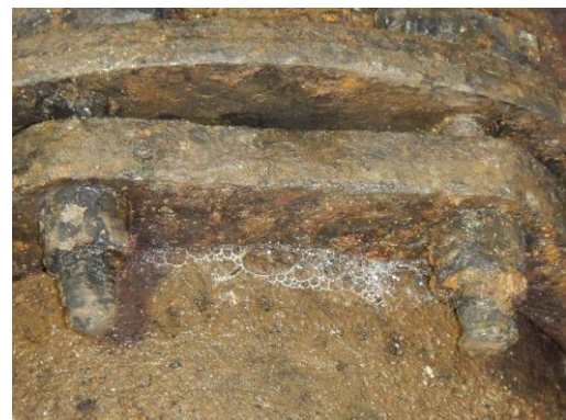
写真4 本管機械的接合 その1 (拡大)
