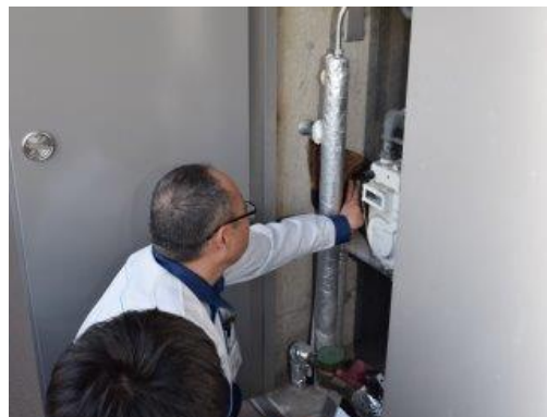
写真10 閉栓作業
