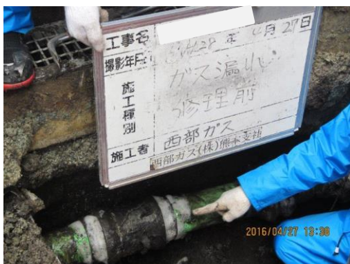
写真7 支管機械的接合 その1
