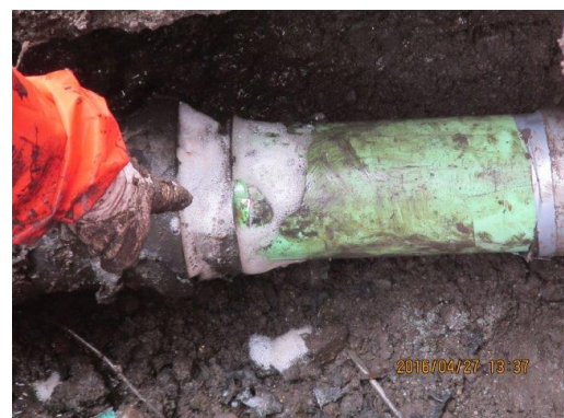
写真8 支管機械的接合 その1 (拡大)
