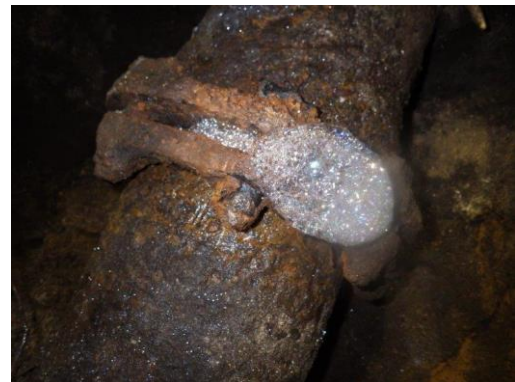
写真6 本管機械的接合 その2 (拡大)
