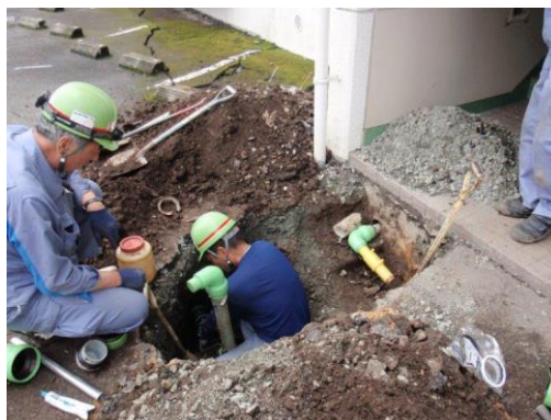
写真16 内管修繕 その2
