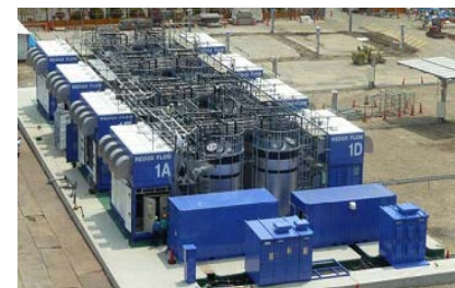
レドックスフロー電池
