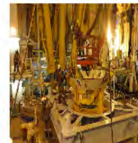
5) GRA(BOPを設置するためのガイド)(GRA_Retrieveable Guideline less Re-entry Assembly)準備作業
