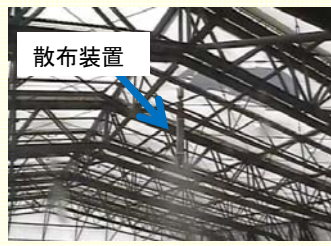
<飛散防止材の散布状況>
