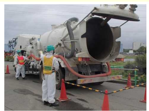
コーンバーによる安全区画の実施
