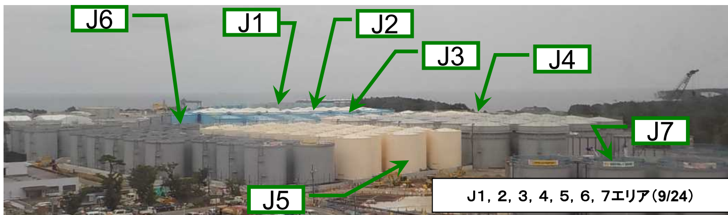
タンク設置状況
