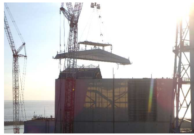
屋根パネル取り外し状況 (1号機建屋山側より撮影)
