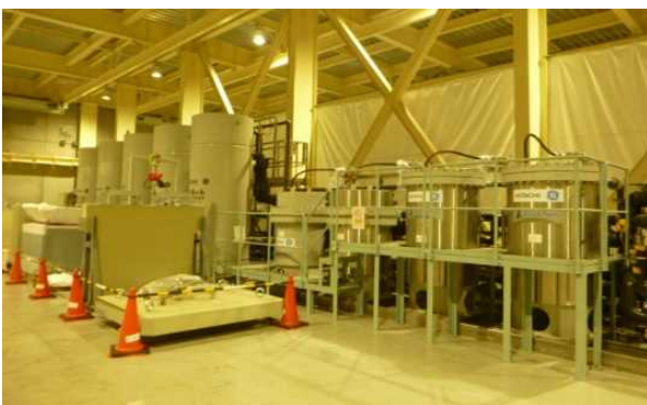
③サブドレン他浄化設備
