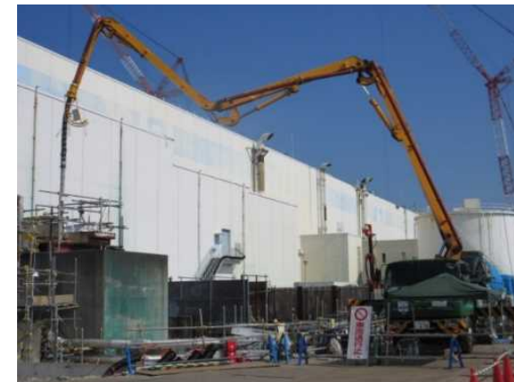
<トレンチ内部充填・閉塞の状況>
