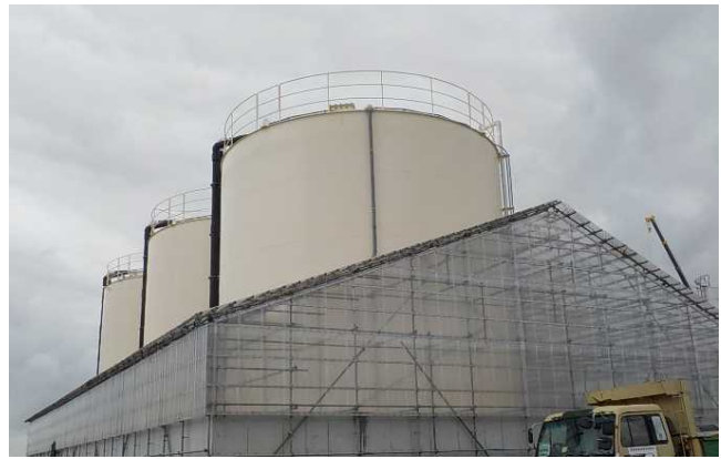
②集水タンク(3基)
