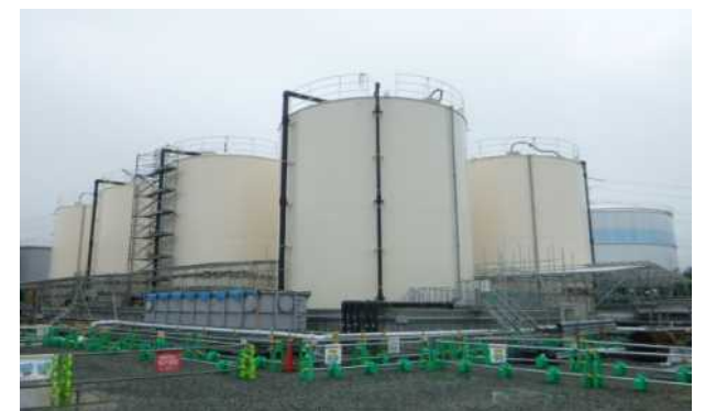
④一時貯水タンク(7基)
