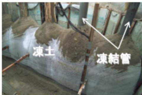
凍結管周囲の土が凍り始めます
