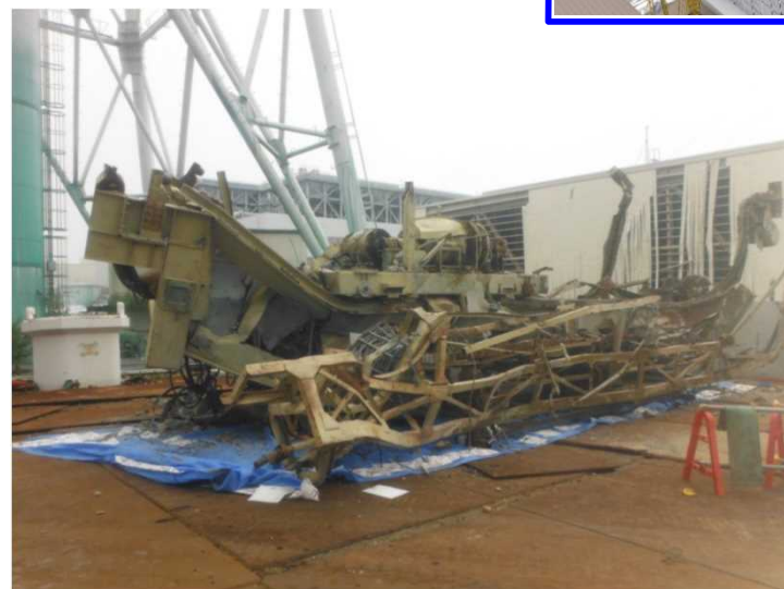
8/2に撤去した燃料交換機
