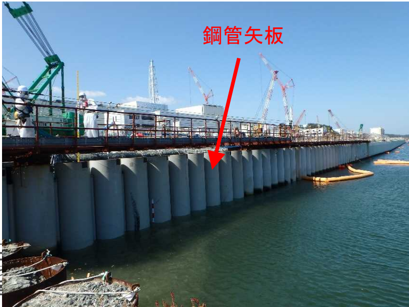
海側遮水壁 (現場状況)
