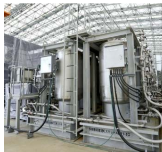
●多核種除去設備
