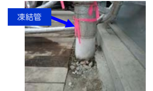
(陸側遮水壁 試験凍結箇所例)
