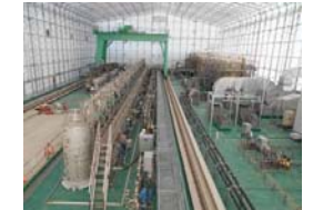
(高性能多核種除去設備)
