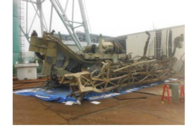
(8/21に撤去した燃料交換機)
