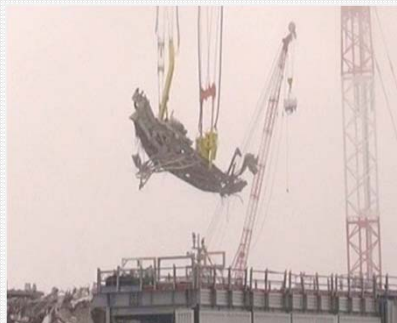
＜燃料交換機撤去作業の状況＞
