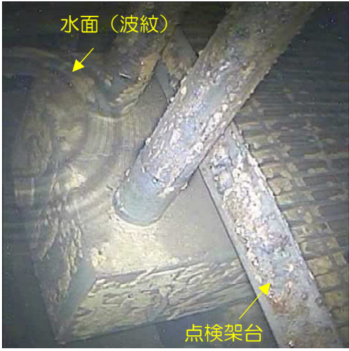
カメラによる調査状況
