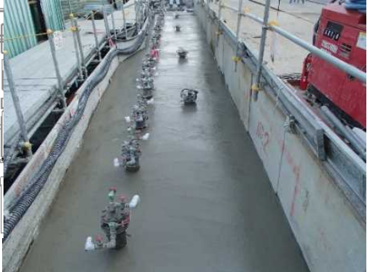
凍結管設置状況 (ブライン配管設置前)
