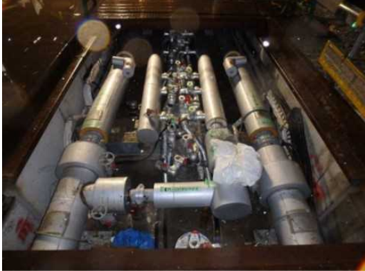
凍結管及びブライン配管設置後
