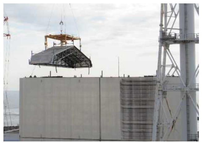
1号機建屋カバー解体作業の状況
