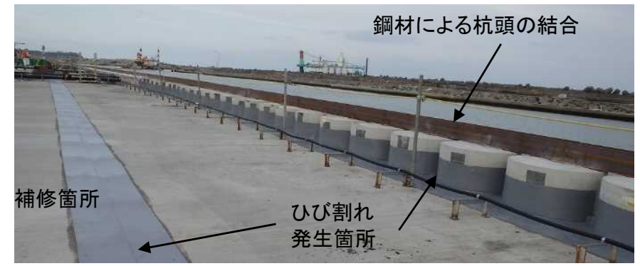
補修実施状況(例)
