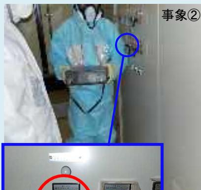
他作業員とすれ違う際に左腕付近の防護服を操作スイッチカバーに引っ掛け、ポンプを停止させた。
