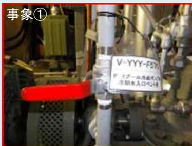
パトロール中の当直員が誤ってベント弁に接触。微開状態となり、系統圧力が徐々に抜け、2次系共通設備のポンプが停止
