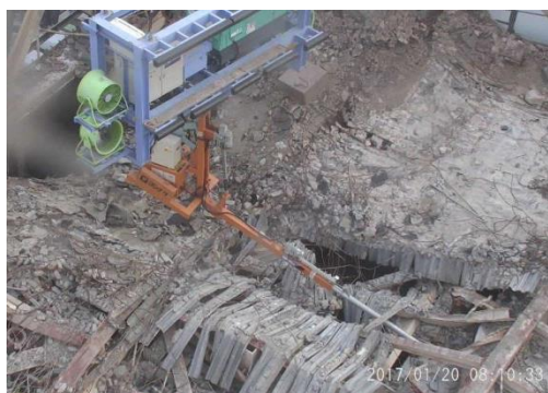
1号機 オペフロ調査の状況
