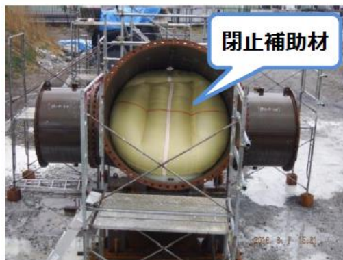
1 / 1スケール試験体で閉止補 助材の止水性能を確認（屋外）
