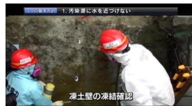
加えて、建屋周囲に、地下水を遮断するための凍土による壁の設置も進めており、2016年10月に凍結が完了した海側では、地下水を遮断する効果が出始めています。
