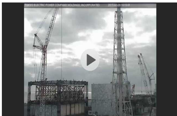
【発電所ライブカメラ映像】
