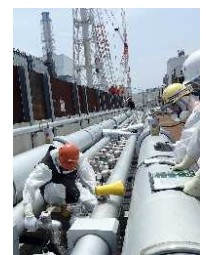
(凍結管バルブ開閉操作の様子)
