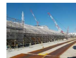
7.5m盤法面屋根架け
