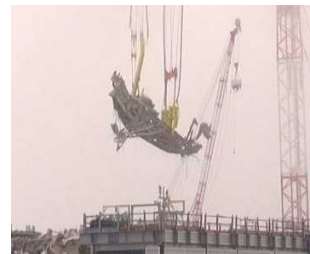
<燃料交換機撤去作業の状況>
