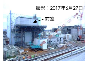
撮影：2017年6月27日 アクセス用構台、前室設置状況
