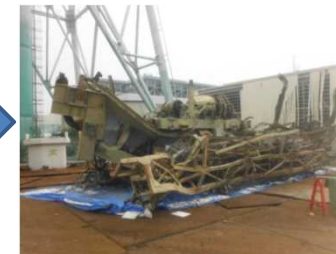
<撤去した燃料交換機>
