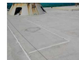
4m盤フェーシング 継手止水
