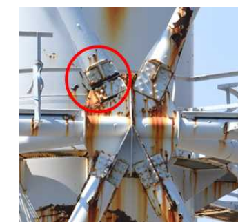
破断箇所（例）
