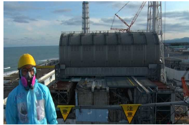
廃炉作業の進捗の解説動画 「3号機燃料取り出し用カバー設置」
