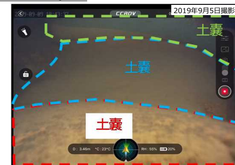
11m付近の縦に並んだ土嚢の状態
