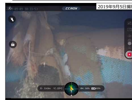
破損しているゼオライト土嚢
