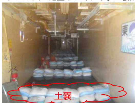
ゼオライト土嚢設置時の状態と設置範囲（最下階平面図）
