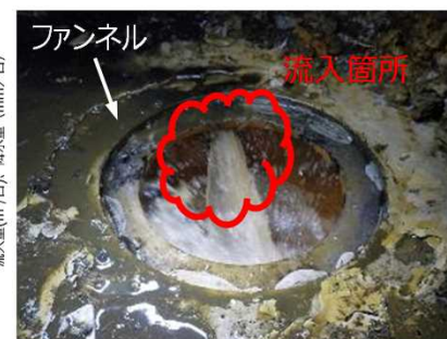
止水対策実施前のファンネルへの流入状況
