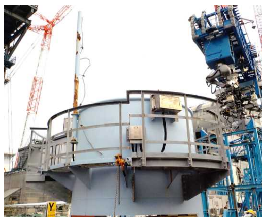
排気筒頂上ブロック解体部材
