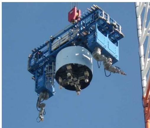
2ブロック吊り降ろし状況
