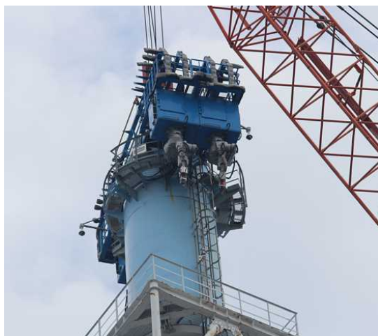
排気筒頂上ブロック切断作業状況
