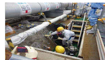
凍土壁確認状況
