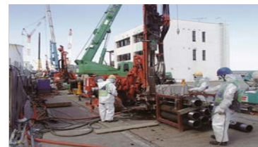
凍結管設置作業状況
