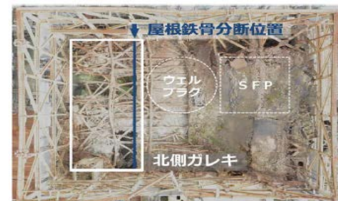
北側の屋根スラブ等撤去後（2018年12月）
