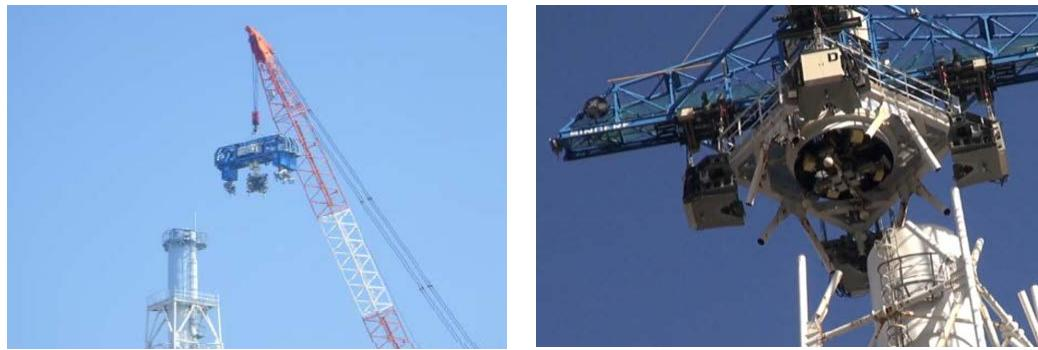
図5 1/2号機排気筒の解体開始（2019年8月）
