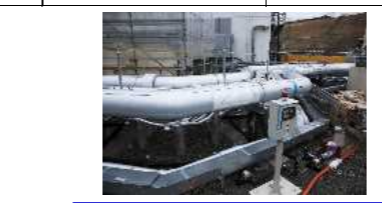
陸側遮水壁ブライン(冷媒)循環配管
