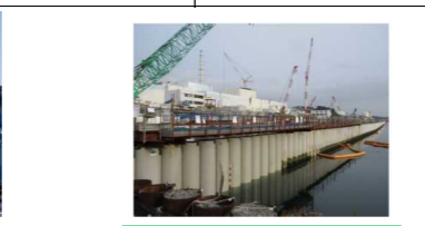
海側遮水壁打設完了の様子
