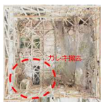
2018年9月 1号機瓦礫撤去状況
