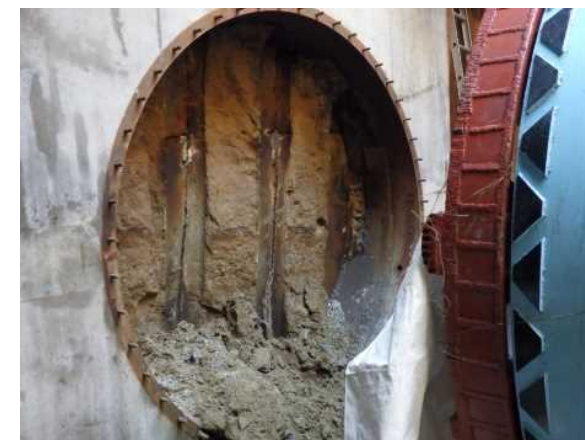
鏡切り完了状況（両発進立坑）（9月7日撮影）
