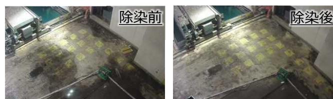
①オペフロ南西部の除染状況
