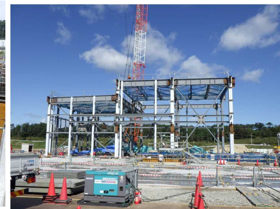
鉄骨工事の状況 (2021年10月20日)
