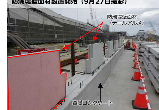
防潮堤壁面材設置開始（9月27日撮影）
