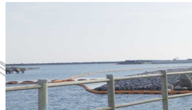
港湾用重油オイルフェンス展張位置を必要に 応じて変更 (黄色点線から黄色実線へ変更)
