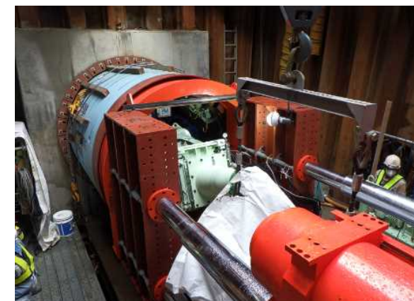
推進機初期掘進状況（両発進立坑）（9月16日撮影）
