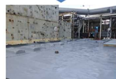
2号機Rw/Bがれき撤去前後 2020年9月 一部エリア完了状況 2020年6月29日: 2Rw/B 500m 2 完了 2020年8月5日: 1Rw/B 100m 2 完了 2020年9月29日: 2Rw/B 500m 2 完了
