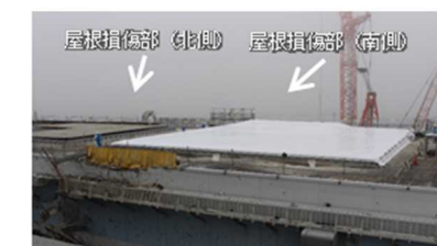
屋根状況【流入防止堰・雨水カバー（南側）設置完了】（西側から撮影）
