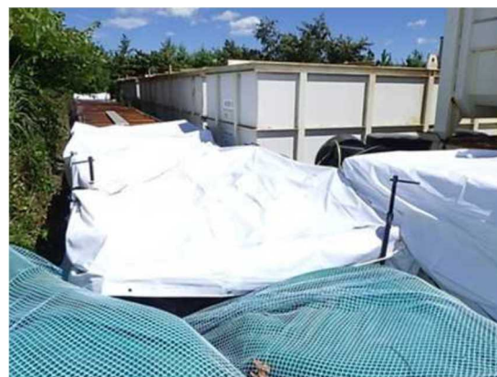
(シート養生後)
