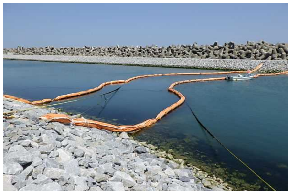
5・6号開渠部既設シルトフェンスの活用と 必要に応じた補強
