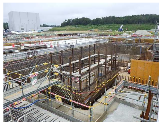
減容処理設備の基礎工事 (2021年8月20日)
