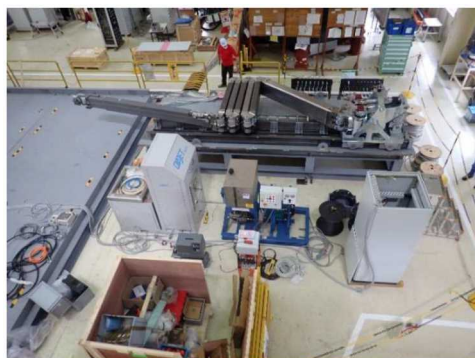
ロボットアーム設置状況
