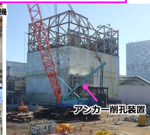
アンカー削孔装置設置状況 (2021年10月11日)
