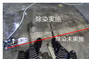
②床面の高圧水除染状況
