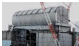
3号機燃料取り出し用カバー 設置状況
