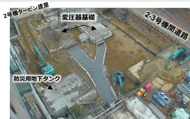
2号機原子炉建屋南側ヤード状況 (2021年9月16日)
