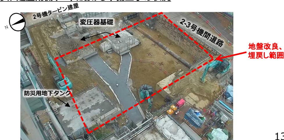
2号機原子炉建屋南側ヤード状況(2021年9月16日)
