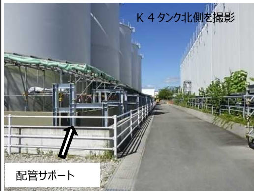
循環配管サポート設置の状況
