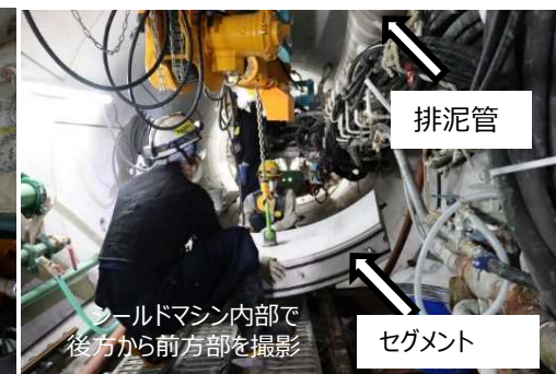
セグメント搬送状況（トンネル内）
