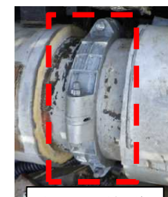
保温材取外し後
