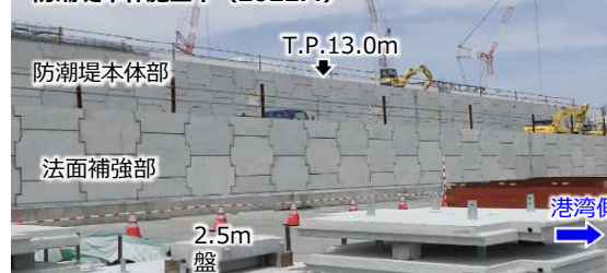
防潮堤本体施工中（2022.4）
