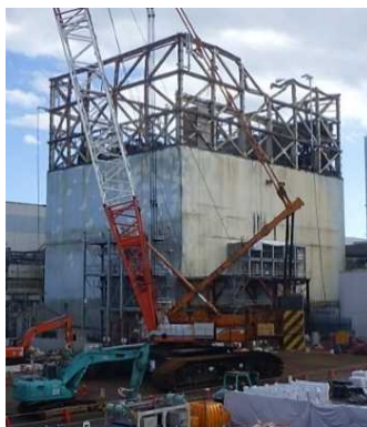
1号機原子炉建屋現場状況
