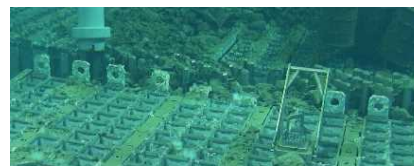
高線量機器（燃料ラック）の状態
