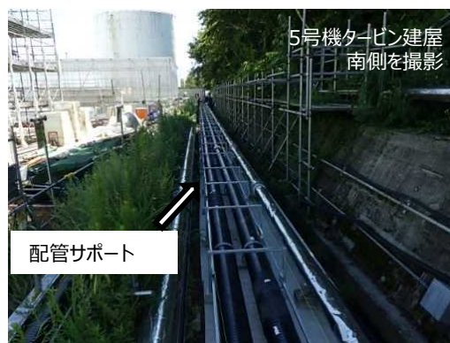
移送配管サポート設置の状況
