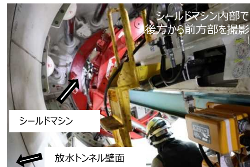
シールドマシン掘進作業の状況
