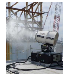
噴霧装置による散水状況
