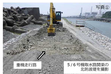
重機走行路整備の状況
