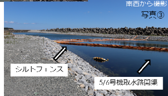
56号海側工事の状況
