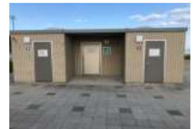
バリアフリー化の対象となる現地のトイレ棟 71
