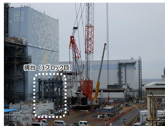
2号機南側ヤードの状況（2023年1月27日）
