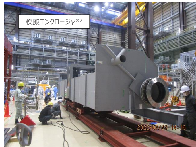
エンクロージャの搬入試験の状況
