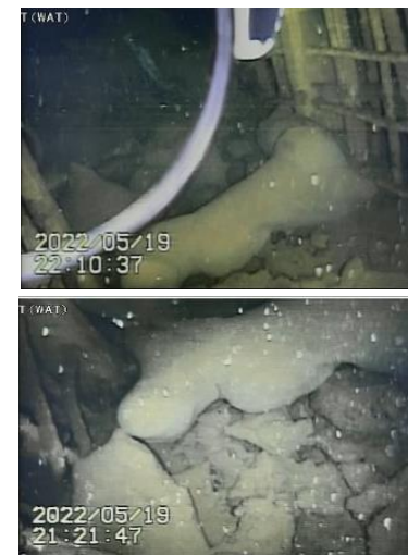
■：塊状の堆積物 E：真空破壊弁からの水漏れが確認されたベント管のジェットデフレクター
