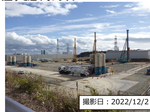
固体廃棄物貯蔵庫第10棟 地盤改良工事状況
