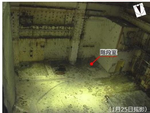
解体後の現場状況写真（2023年1月25日撮影）
