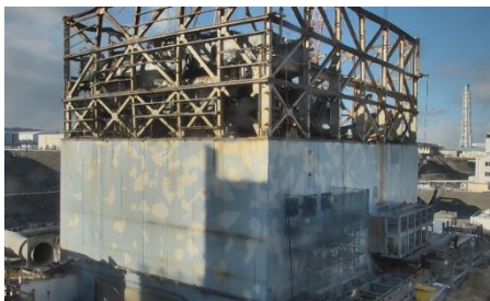
1号機原子炉建屋現場状況
