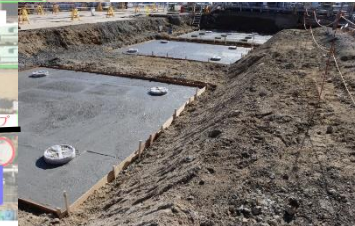
海水移送配管基礎の構築状況
