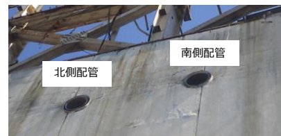
IC配管撤去後の現場状況 (西面) (撮影：2022年9月29日)
