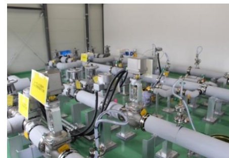
ALPS処理水移送設備 （処理水移送ポンプ 出口放射線モニタ）▶
