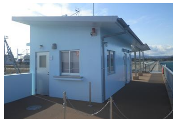
改修予定の施設
