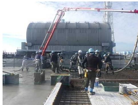
構台上 床部コンクリート打設状況
