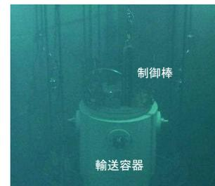
輸送容器への制御棒装填状況
