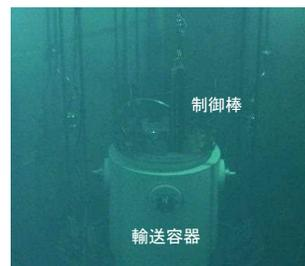
輸送容器への制御棒装填状況
