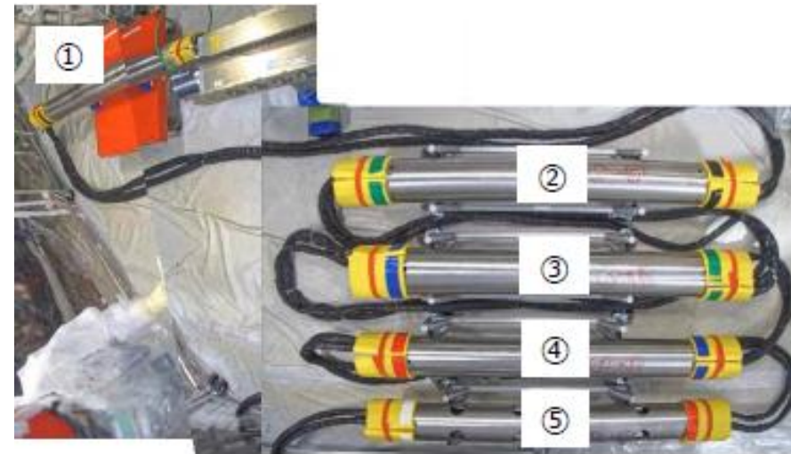
押し込みパイプ並び換え後
