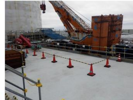
建屋周辺の舗装
