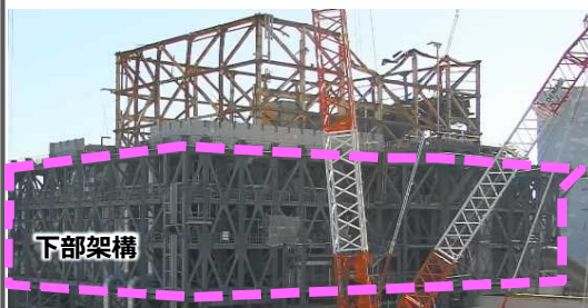
現場状況（北西面）（2024年11月4日）
