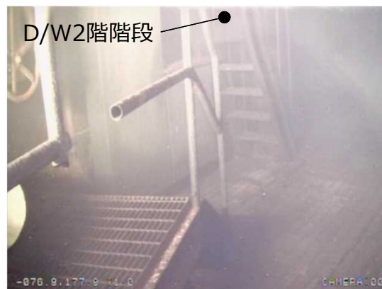
(2021年10月15日) PCVアクセスルート構築作業時
