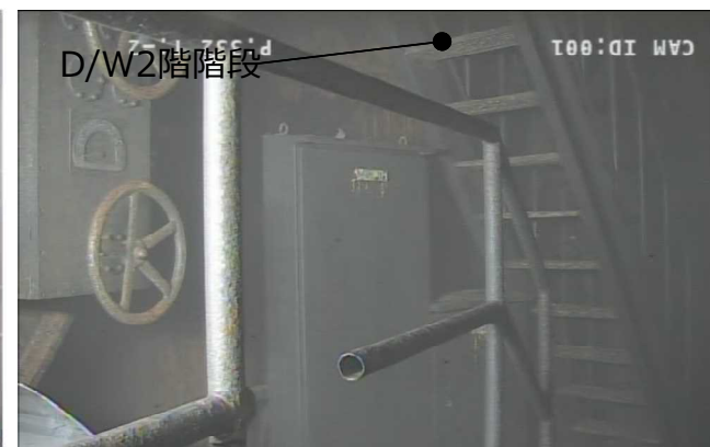
(2024年9月30日) PCV内部環境調査 1日目
