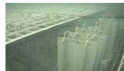
使用済燃料プール内水中カメラ調査状況 制御棒貯蔵ラック
