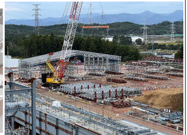
構外ヤードの状況（2024年11月5日）
