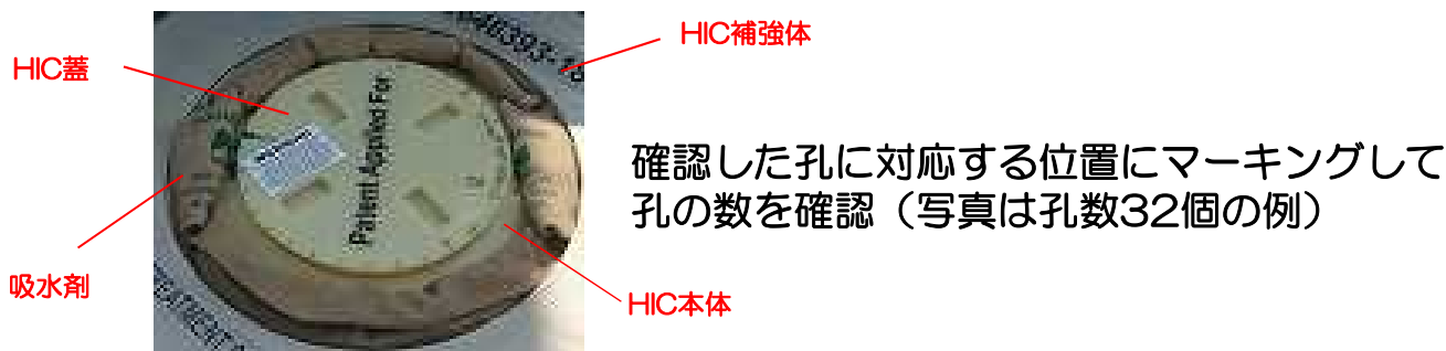
蓋ベント孔の数の記録がないものの点検状況
