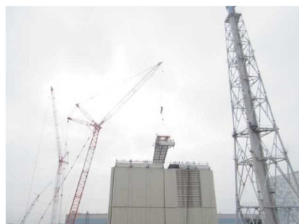
1号機建屋山側より撮影
