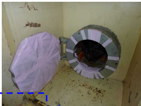
段差とおもわれる箇所
