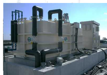
②地下水ドレン中継タンク (3基)
