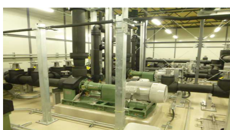
②浄化水移送ポンプ・攪拌ポンプ (各2台)
