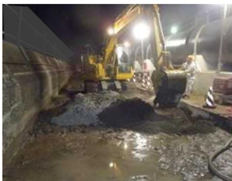
写真② 南護岸部 地盤改良工
