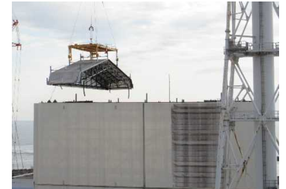
(1号機建屋カバー解体作業の状況)
