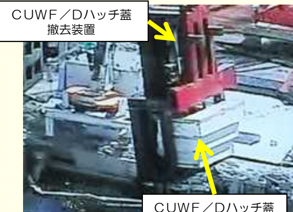
＜CUW F/Dハッチ蓋撤去作業状況＞
