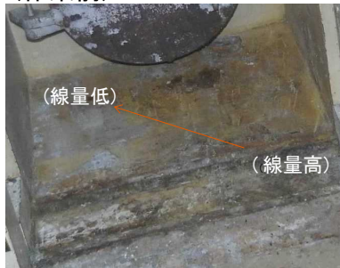
(溝部のスチーム洗浄水回収作業)
