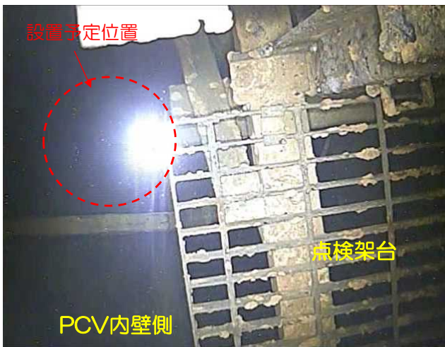
水面・点検架台周辺 (X-53ペネ下側近傍)
