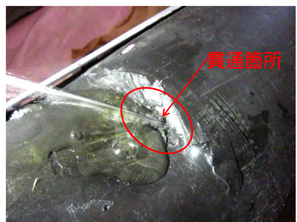
貫通箇所の確認の状況
