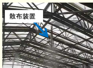
<飛散防止材の散布状況>
