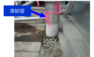
(陸側遮水壁 試験凍結箇所例)
