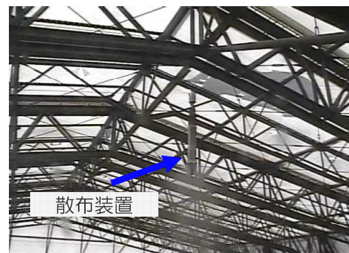
北2屋根パネル飛散防止剤散布状況 (カバー内)
