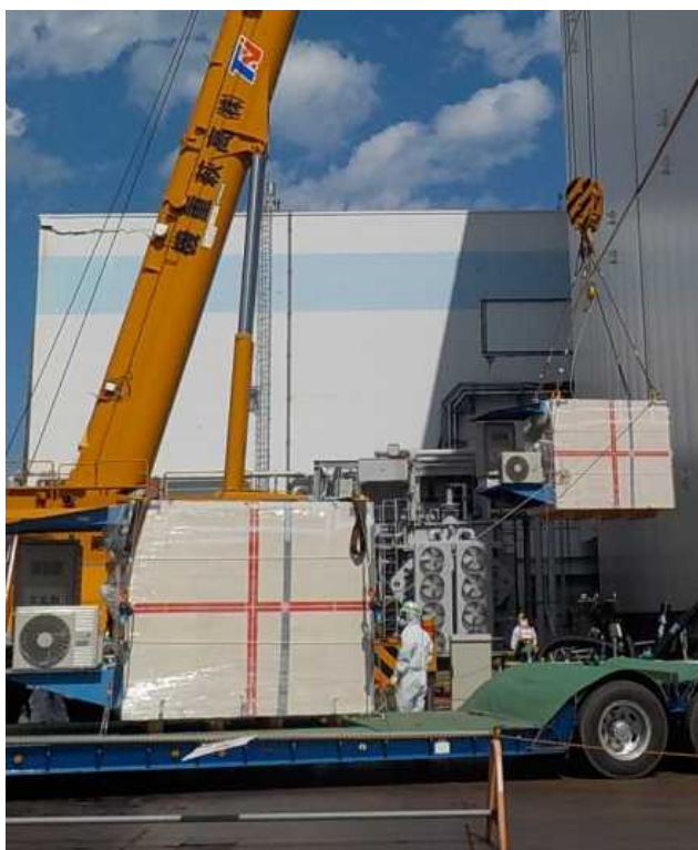
写真1 クレーンによる荷下ろし作業
