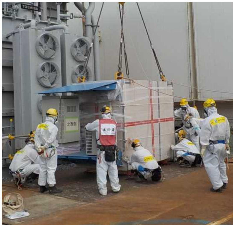
写真2 測定装置1(北西側→北側)の移動作業
