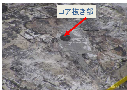
D部 オペフロ北側コア抜き状況
